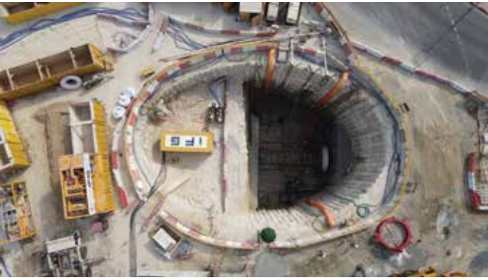
متابعة أعمال الخط الأوسط لتصريف مياه الأمطار.
